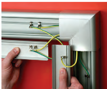
Количество монтируемых проводов заземления в плоском угле
