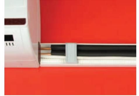
Закрепите трассу в основании короба при помощи фиксирующих скоб
