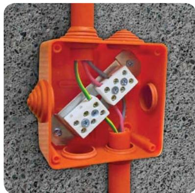
Керамический клеммник, устойчив к температуре до 1000°C
