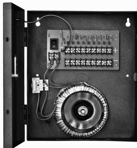
Профессиональные многоканальные блоки питания ST-PS205-9 предназначены для высококачественного электропитания напряжением 24 В переменного тока оборудования видеонаблюдения и других устройств без необходимости резервирования питания. Индивидуальная защита по каждому выходному каналу с помощью
