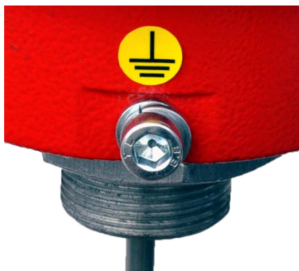
Рис. 4 – Место заземления на корпусе извещателя
