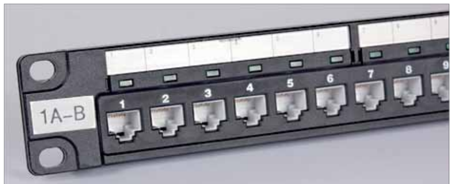
Рис. 2. Пример маркировки коммутационной панели
