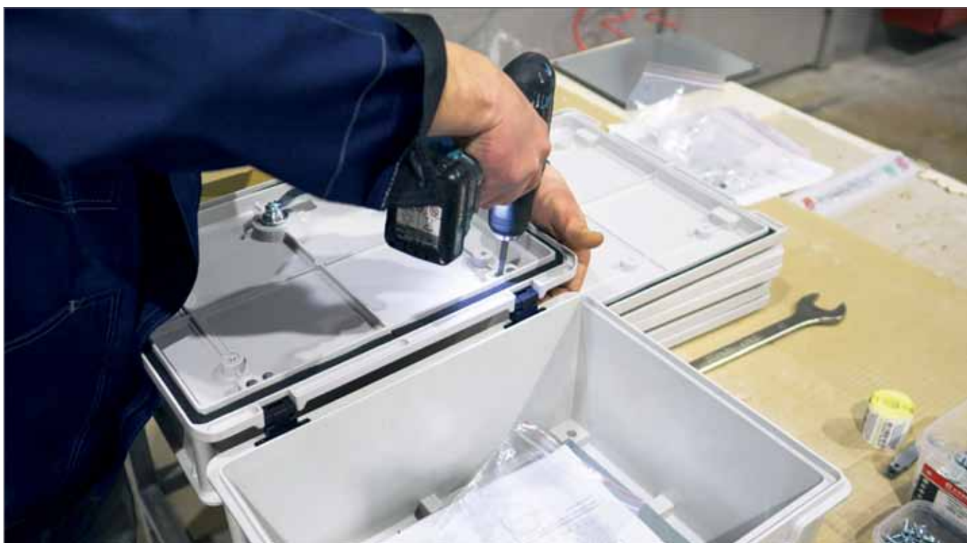
Фото 2. Ручная сборка монтажных шкафов из SMC-композита
